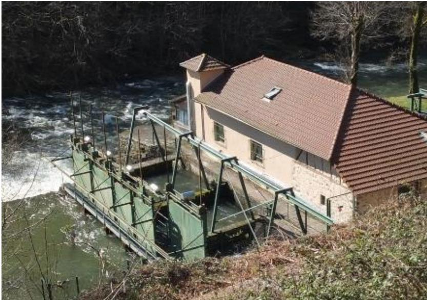
Photo 6 : Les 5 vannes de garde ouvertes au maximum (crédit : HYDROCOP)
